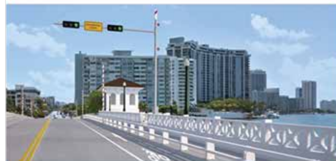
Alternativa de sección típica: T3 – Barandas de Wyoming TL-3 en el contén y Barandas originales de Venetian en las uniones
